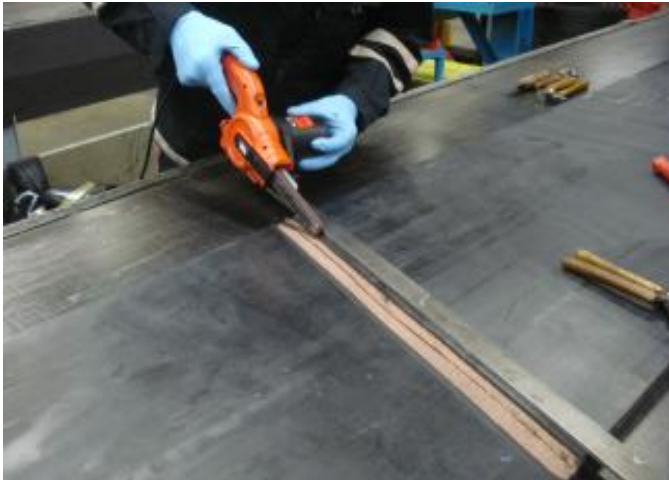
Fotografía 13. Pulir el caucho de cubierta existente
