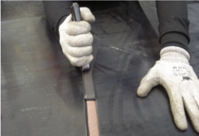
Фото 4. Снятие резиновой обкладки
