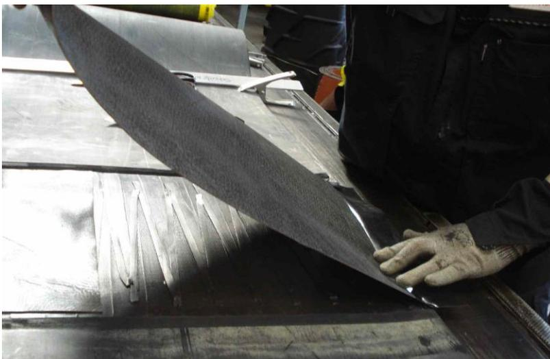
Das gummierte Gewebe dicht um die Karkasse wickeln.
