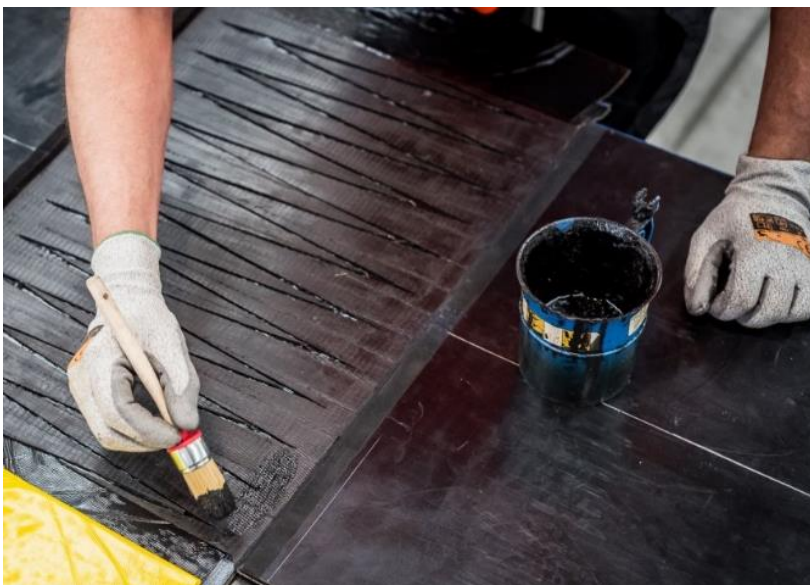
Bild 23: Dundisol dünn auf die Finger aufbringen
