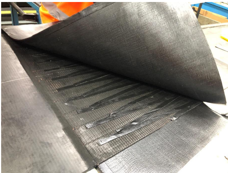
Foto 25: Colocando la cobertura superior preparada
