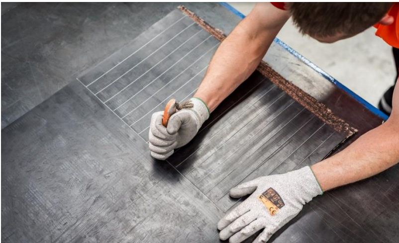
Foto 5: Cortando las coberturas
