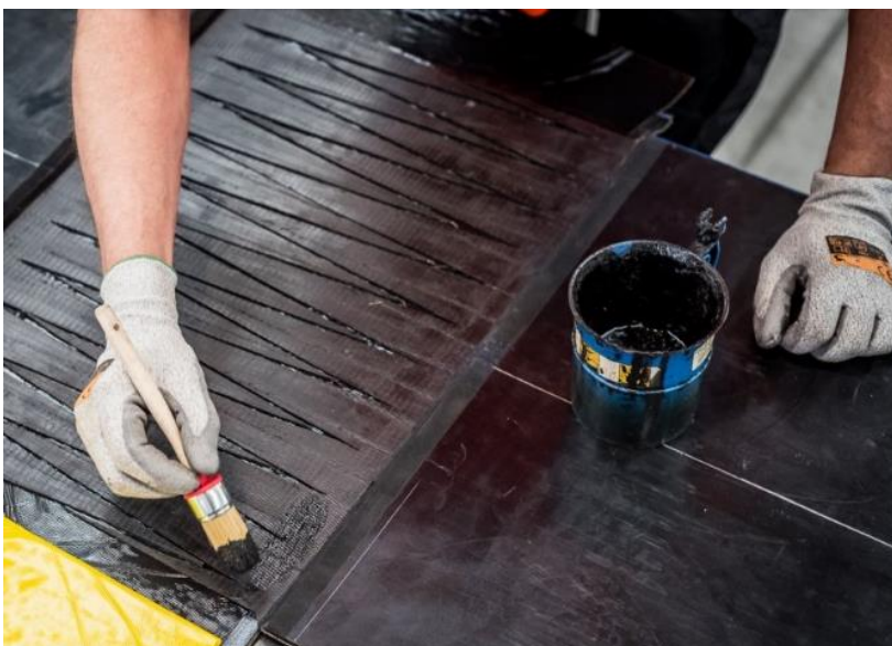
Foto 23: Solución sobre los dedos sobre la cobertura superior
