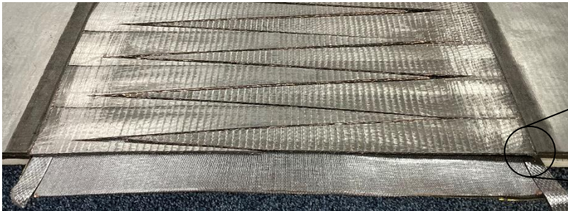
Foto 22: Posición correcta de la cobertura inferior
