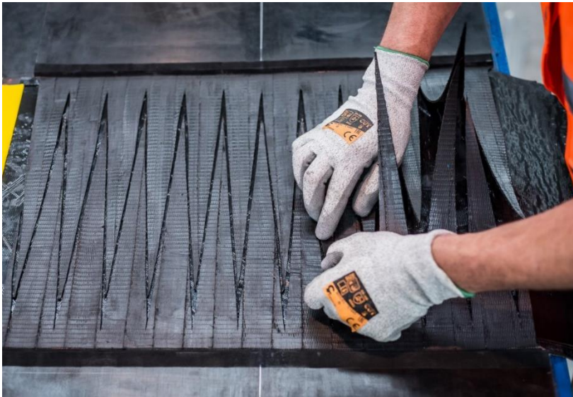
Photo 21: Mise en place des deux extrémités de la bande
