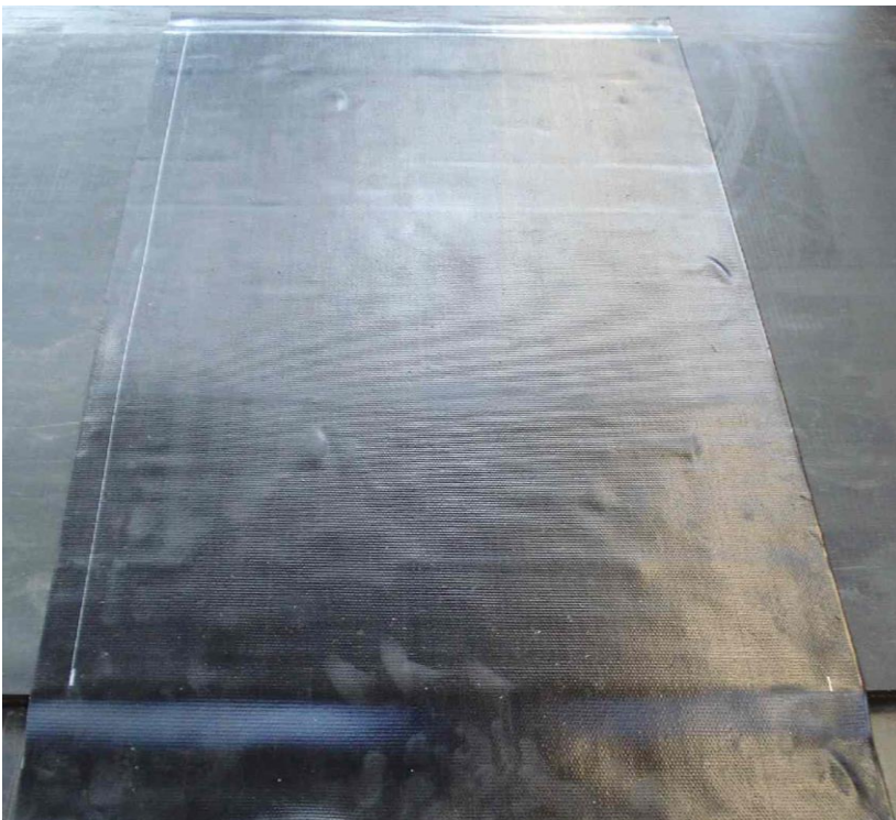
Foto 15: Voorbereiden nieuwe onderdeklaag
