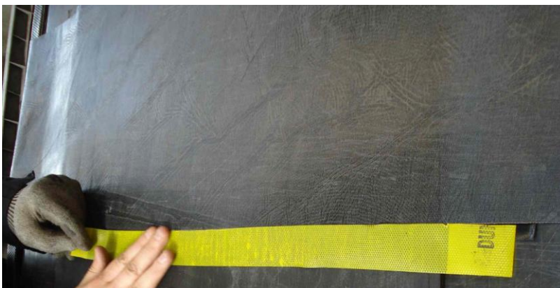
Bild 17: Den Raum neben dem Gewebe ausfüllen
