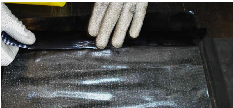
Bild 29: Gummikante anbringen
