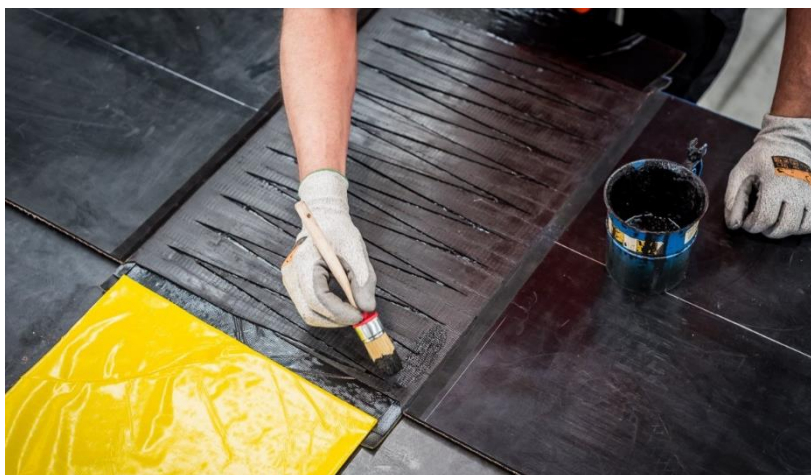
Bild 21: Dundisol dünn auf die Finger aufbringen
