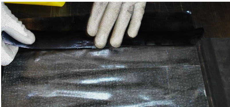
Foto 29: Aplicando caucho en los bordes
