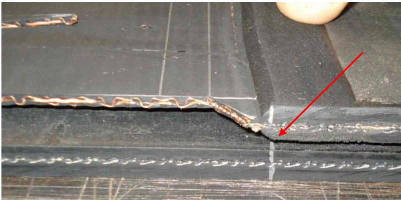
Marquage de la position de l'extrémité de bande pour repositionnement ultérieur.
